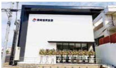
安城支店(2024年6月建て替えオープン)
