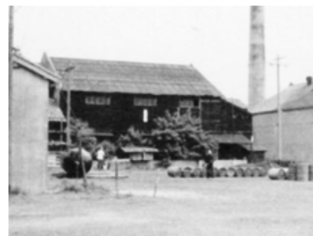
抽出工場とボイラー室
