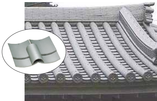
本瓦で葺かれた屋根。平瓦を葺いた上に丸瓦をかぶせる。
